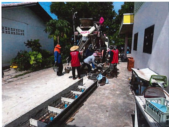
โครงการก่อสร้างรางระบายน้ำ คสล. หมู่ที่ ๑๒ (ซอยโคกแมงเงา ๔)
