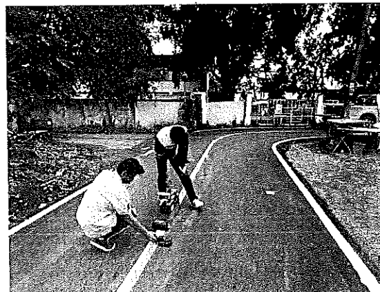
- ก่อสร้างปรับปรุงถนน คสล.เป็นผิวทางแอสฟัลต์ติกคอนกรีต เส้นหลังโรงเรียน หมู่ที่ ๖ (ซอยหลังโรงเรียน ๒)
