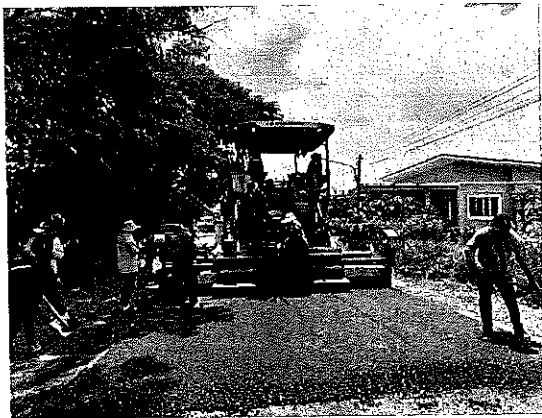
- ก่อสร้างปรับปรุงถนน คสล.เป็นผิวทางแอสฟัลต์ติกคอนกรีต เส้นหลังโรงเรียน หมู่ที่ ๖ (ซอยหลังโรงเรียน ๒)
